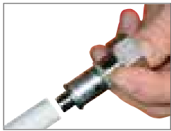
3、将管接配件插入管子中
